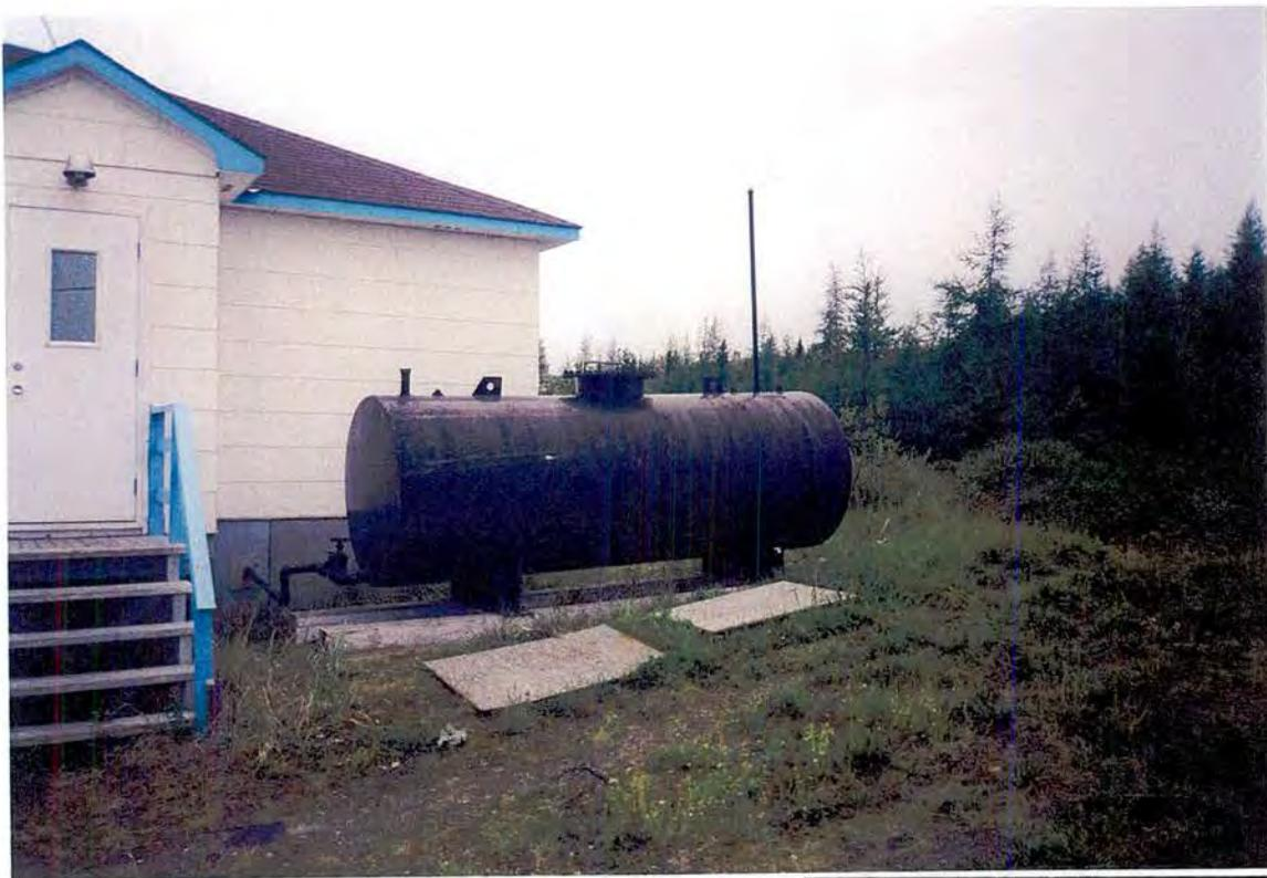
Photo n° 39. Réservoir de mazout 2 273 litres – Centre de désintoxication.
