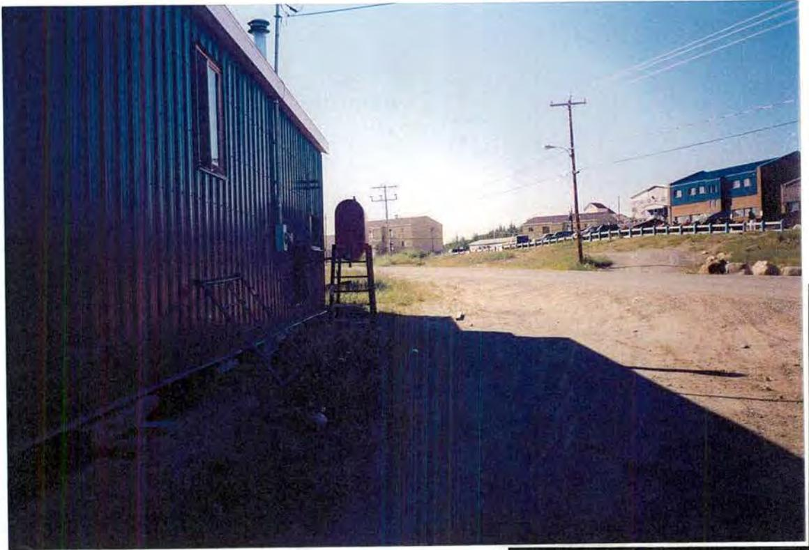
Photo n° 41. Réservoir de mazout 1 136 litres – Inuksiutiit Artic Food.
