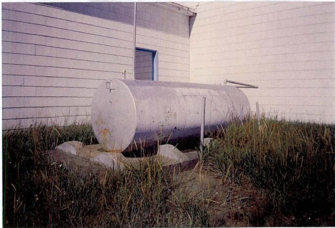
Photo n° 8. Réservoir de mazout 9 090 litres (T-141).
