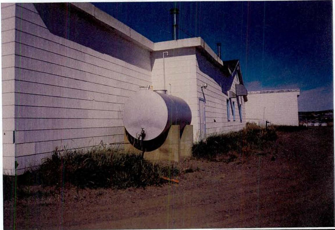
Photo n° 7. Réservoir de mazout 4 545 litres (T-141).
